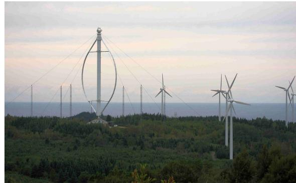
2.54 : Quelques-unes des éoliennes du parc éolien de Cap-Chat, dont Éole, la plus haute éolienne à axe vertical au monde.
